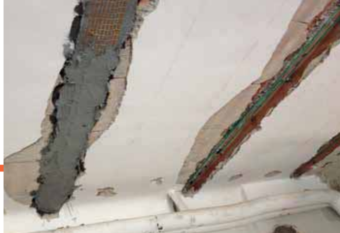
Esempio di solaio con ferri esposti e passivati con Rurecoat 3, travetto con rinforzo FRCM Ruregold XS Calcestruzzo e matrice Ruregold MX Calcestruzzo.
