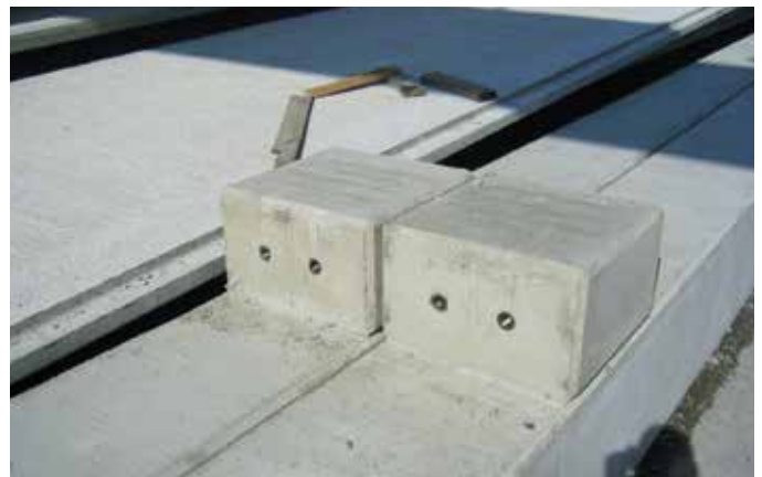
Applicazione tipica del giunto trave pilastro
