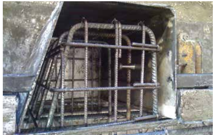
Predisposizione della Boccola RUR nel cassero
