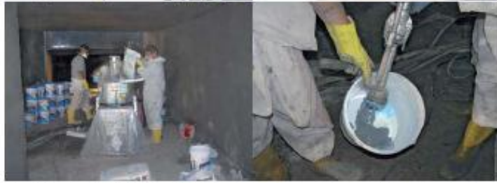
Protezione superficiale sopra rinforzo Ffp per il ponte Tre Archi di Castropignano, Campobasso.
