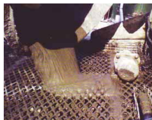
L'impiego delle fibre Ruredil X Fiber 54S non altera la lavorabilità del calcestruzzo.
