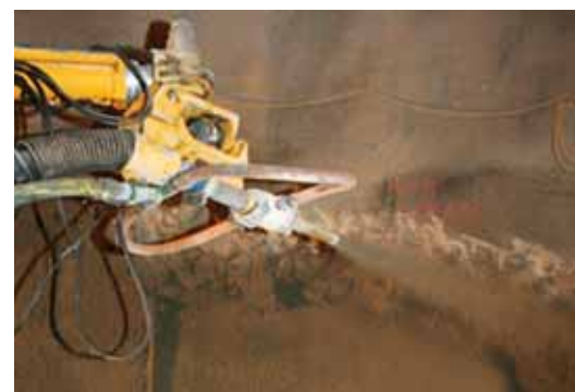
Proiezione di calcestruzzo fibrato con Ruredil X Fiber 54S.
