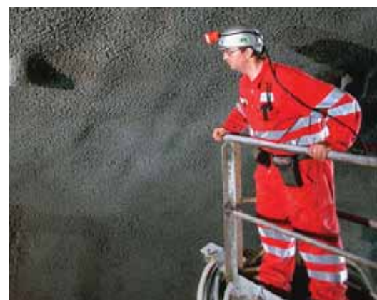
Controllo qualità scavo preconsolidato tramite shotcrete.
